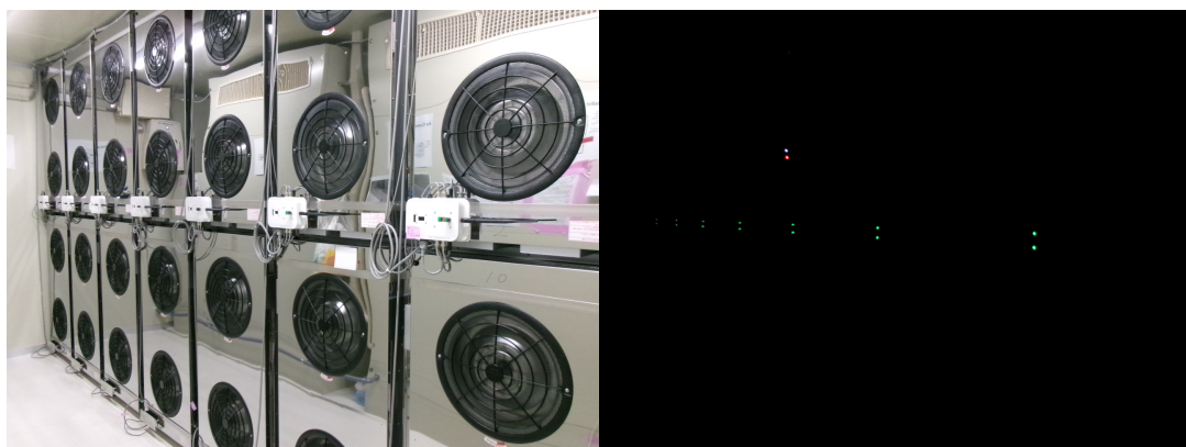
図1. クリーンルームで稼働中のFFUとFFU制御ユニット 左：照明点灯時 右：照明消灯時 FFUの正常稼働を示す緑LEDが、1台のユニットにつきFFU2台分点灯している
