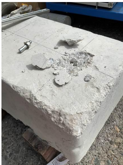
図2 アンカーの抜け出し事例
