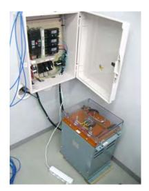
図6 コンテナ内の分電盤とダウントランス
