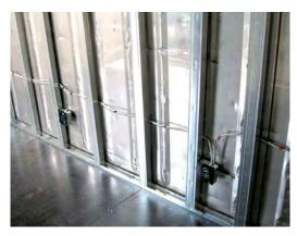
図7 施工中のコンテナ内の壁 合板を張る前で軽天と電源配線が見える
