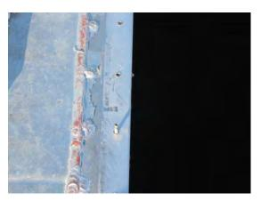
図 13 ドーム天窓を取り付ける開口部の縁 ナットリベッターが付けられている
