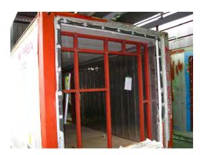
図 5 冷凍ユニットを取り外した部分に 作られている壁と入口の骨組
