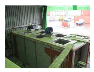
図 12 施工中の受信コンテナの屋根
