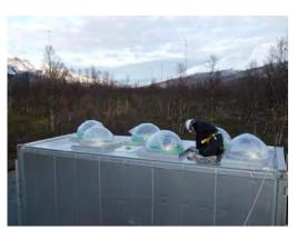
図 22 送信コンテナに取り付けられたドーム天窓
