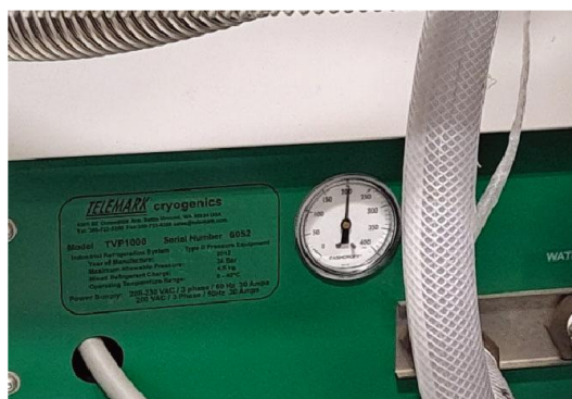
修理後（冷媒充填後）の状態
