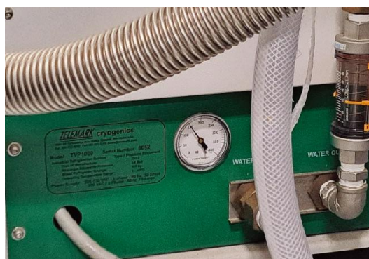
修理前（冷媒充填前）の状態
