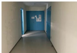
廊下上の避難障害物の有無
