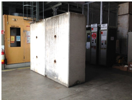
図 2 設置されたコンクリート遮蔽壁
